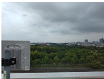
・アンテナ設置写真(防災センター)
